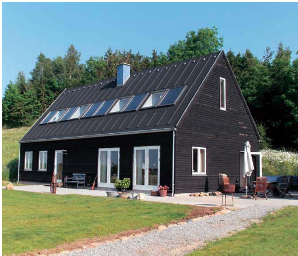
Svanholm Træ & ØkoBygs arkitekttegnede Længehus på 176 kvm er i stand til at akkumulere både passiv og aktiv solvarme. Huset er opvarmet med en kombination af et træpillefyr og solfangere. Overskudsvarmen fra solfangerne lagres i et sandlager under huset – det er med til at holde den samlede udgift til opvarmning nede omkring 1.500-1.600 kr. - om året!
