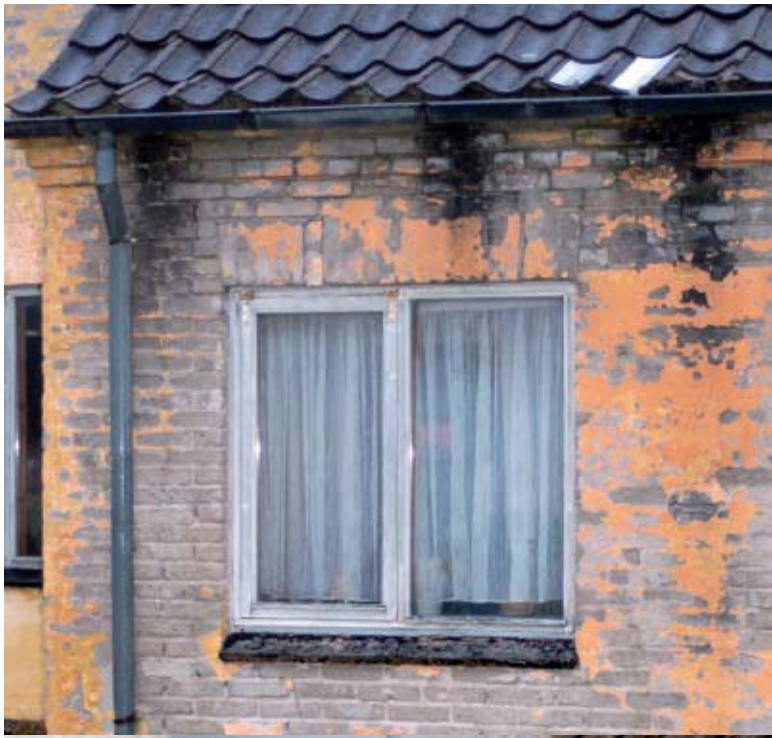
Utætte tagrender og tage kan lede til skader på murværk og skimmelproblemer.
