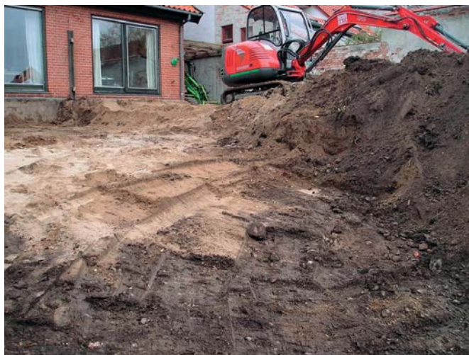
Afgravning af jord i en forurennet parcelhushave.
